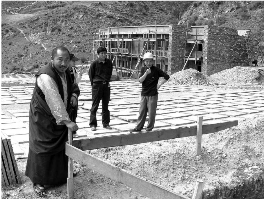
Besichtigung des Baufortschritts: im Hintergrund das Gebäude mit den neuen Klassenräumen
